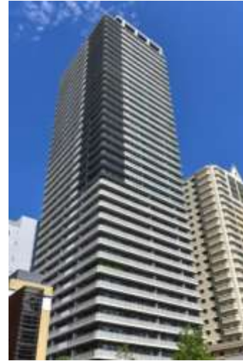
ルネッサなんばタワー 38F 鹿島建設 大阪
