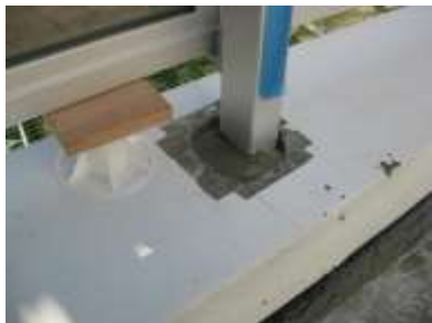
⑧グラウト注入
