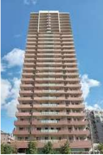
カスターリアタワー長堀橋 28F 浅沼組 大阪
