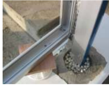
④セラミックボール充填・オーバルレジン注入
