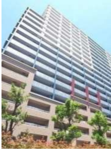
ザ・ミレナリー Towers 20F 鴻池組 東京
