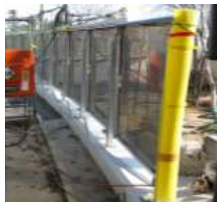
⑥太陽光パネル設置
