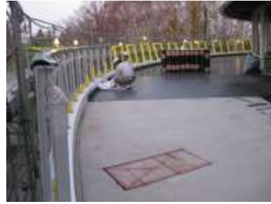
③間配り・仮設置・仮組立
