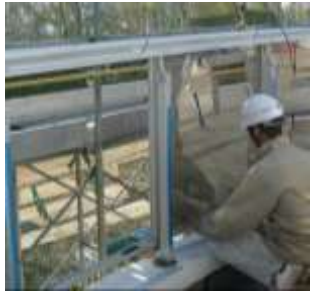
⑥太陽光パネル設置
