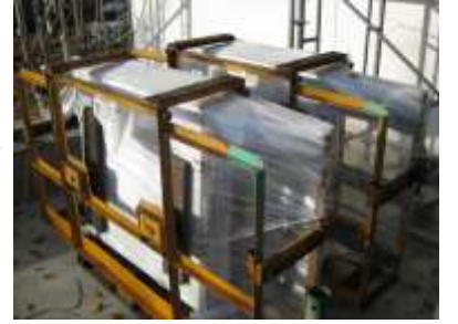
⑤太陽光パネル搬入
